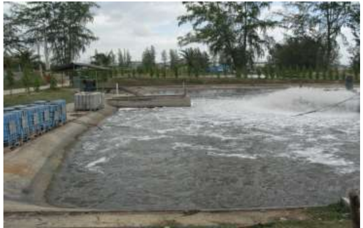
บ่อให้อากาศ 1 หลังใช้พิโก
