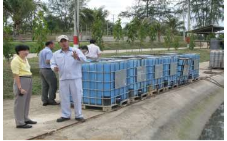
บ่อให้อากาศ 1 - เติมไซรัปเสียที่รับจากโรงงานเครื่องดื่ม
